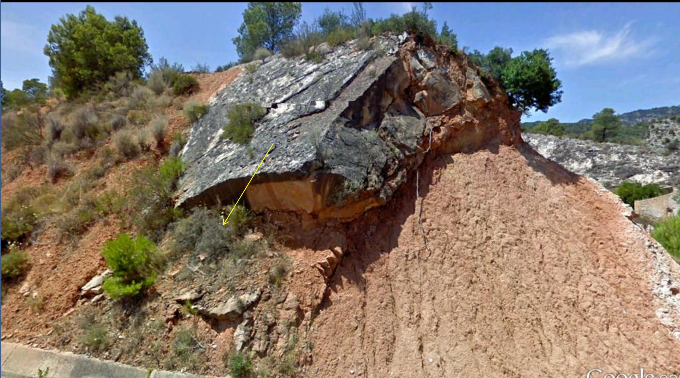
Metaestabilidad en el talud de areniscas y arcillas del Paleoceno, Terciario, Al S de Pinell de Bray, Tarragona, NE Hoja Horta de San Juan.
